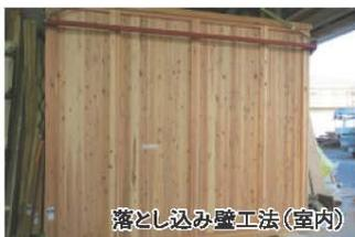
落とし込み壁工法(室内)
