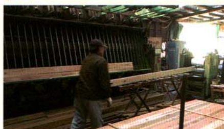
①小幅板の小口に接着剤を塗布し並べる
